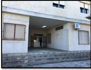
Figura 4. Entrada trasera al edificio principal de la Facultad sin rampa ni puerta automática. Y sin señalizar.
