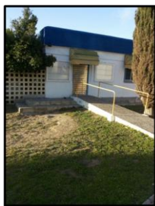
Figura 10. No hay nada que indique que este edificio anexo es la copistería.
