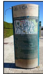
Figura 7. Panel de señalización en la entrada principal al recinto de la Facultad: Partes borradas (defectuoso sin mantenimiento), Letra pequeña, Información no actualizada.
