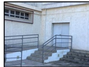
Figura 9. Entrada a los laboratorios de Psicología y de Actividad Física y del Deporte sin señalizar.
