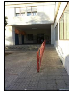
Figura 8. Entrada trasera al edificio sin señalizar.
